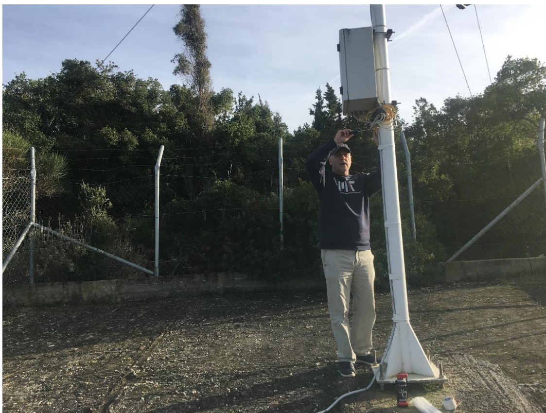
Εικόνα 1.2-4: Απο τις τεχνικές εργασίες στον σταθμό ΚΕΦ-1 στις 17/12/2022.
