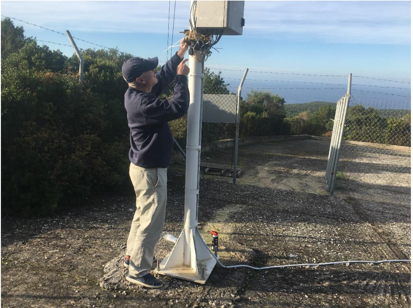
Εικόνα 1.2-6: Απο τις τεχνικές εργασίες στον σταθμό ΚΕΦ-1 στις 17/12/2022.
