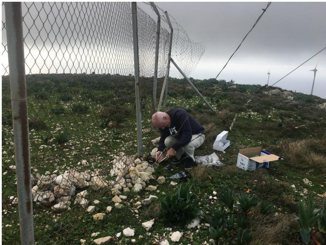
Εικόνα 1.2-3: Απο τις τεχνικές εργασίες στον σταθμό ΚΕΦ-2 στις 16/12/2022.
