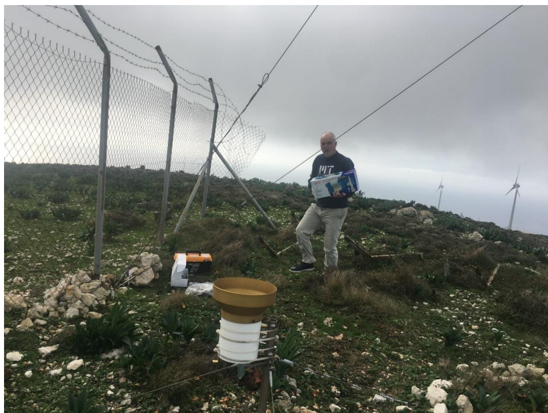
Εικόνα 1.2-2: Απο τις τεχνικές εργασίες στον σταθμό ΚΕΦ-2 στις 16/12/2022.
